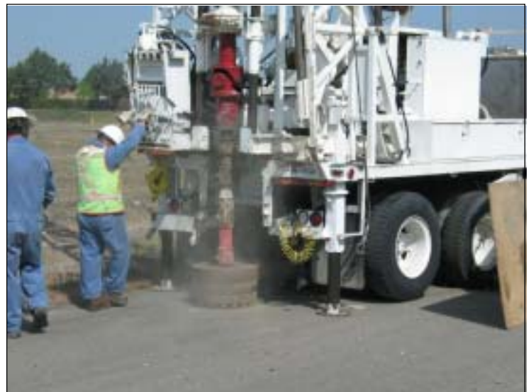
Como parte del nuevo programa dirigido a concluir la limpieza en un periodo de cinco años, los contratistas del Patio de Tanques se disponen a perforar un nuevo pozo para extracción de vapores en abril de 2007.
