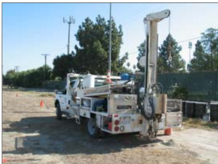
En abril de 2007 se instalaron nuevos pozos de insuflación de aire en el límite oriente de las instalaciones.
